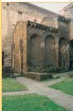
▲ Cámara Santa. Vista exterior desde el nordeste.
